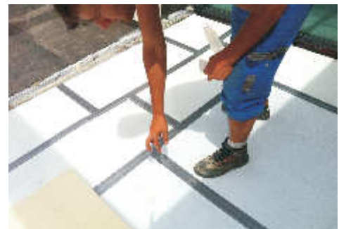
Fertig verlegte Fläche
