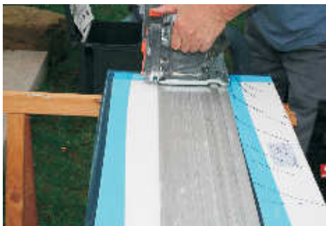
Zuschnitt des Ausgleichselementes auf der Baustelle
